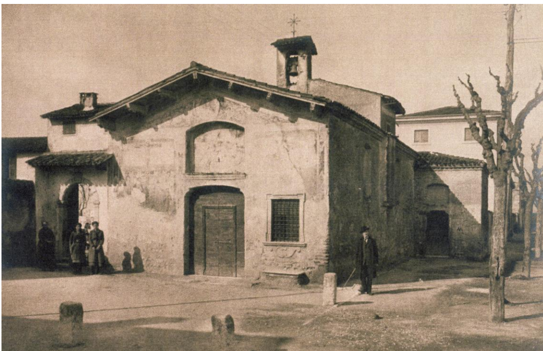
Anno 1930: Foto ricordo di Marcello Fantoni ritratto davanti alla chiesa di San Rocco. Si notino i sassi a vista nella parte bassa della struttura prima dell'intervento di restauro del 1933.
